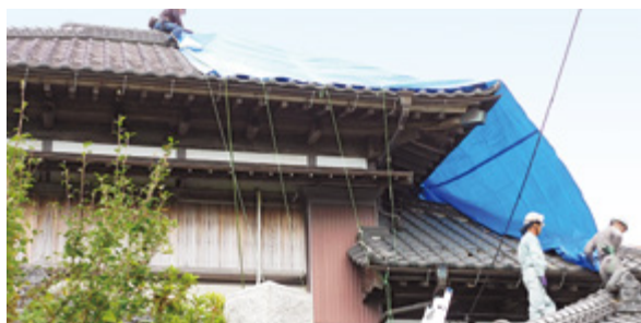
ブルーシート張りに協力
