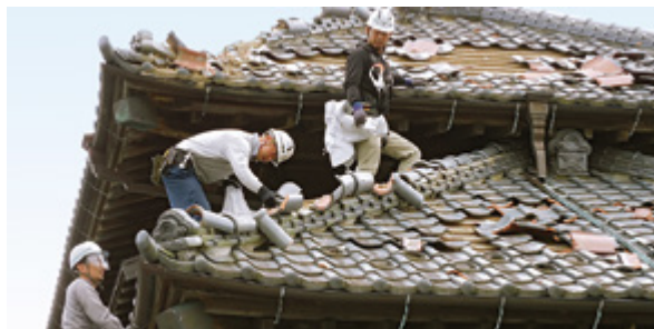
壊れた屋根瓦の撤去を行いました
