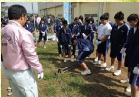
基礎工 鉄筋切断・加工作業
