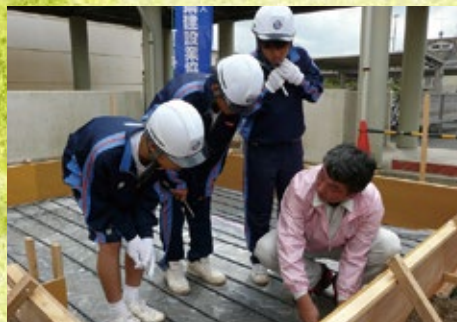
基礎工 鉄筋組立・結束作業
