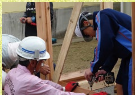
木工・組立 組立作業
