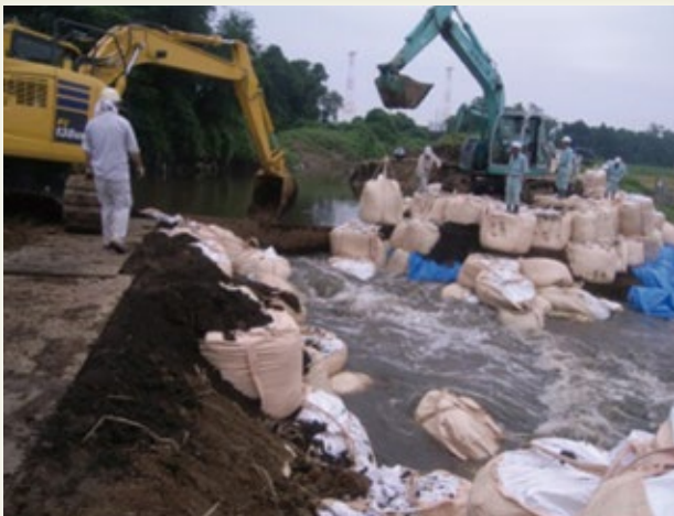
西仁連川決壊現場。大きく決壊した箇所に大型土のうを設置して止水作業。
