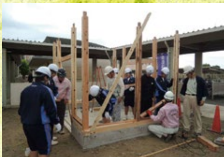
木工・組立 建方
