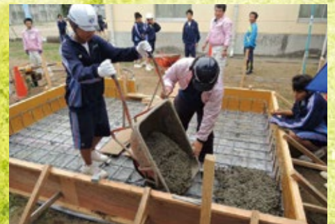
基礎工 生コン打設作業
