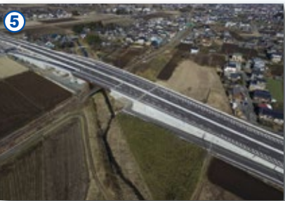
一般県道菅谷小原内水戸線 (下菅谷跨線橋)
