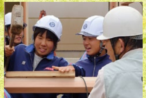
木工・組立 組立作業
