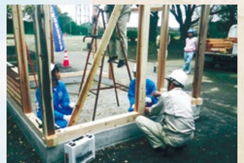
木工・組立 組立作業
