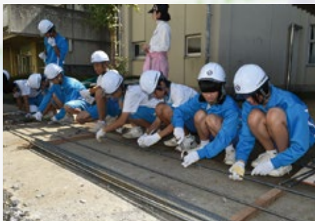
基礎工 鉄筋切断・加工作業
