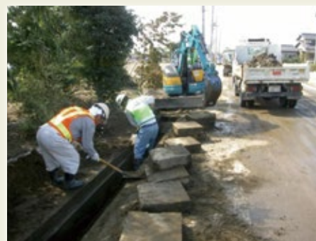
V字溝のふたを開け、小型バックホウと手作業で土砂をかき出す。
