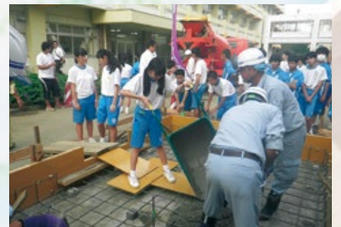
基礎工 生コン打設作業
