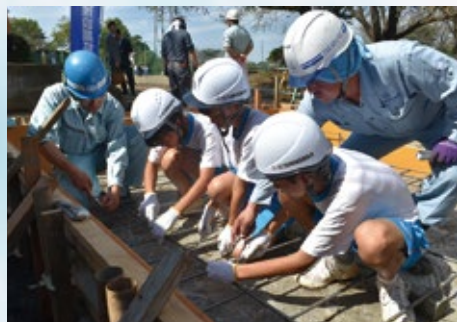
基礎工 鉄筋組立・結束作業
