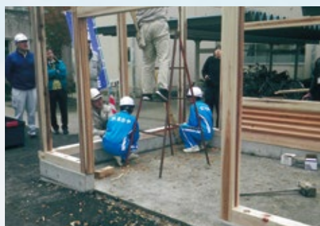
木工・組立 組立作業
