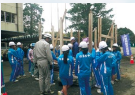
木工・組立 建方
