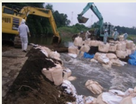
西仁連川決壊現場。大きく決壊した箇所にて大型土のうを設置して止水作業。
