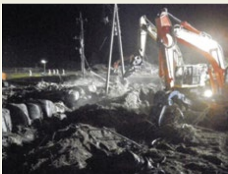
照明を設置して24時間態勢で復旧作業にあたる地元建設業者。
