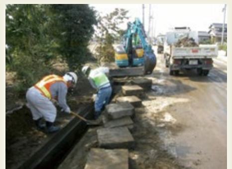
V字溝のふたを開け、小型バックホウと手作業で土砂をかき出す。
