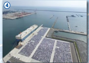
④ 茨城港常陸那珂港区
