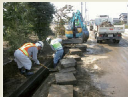
V字溝のふたを開け、小型バックホウと手作業で土砂をかき出す。
