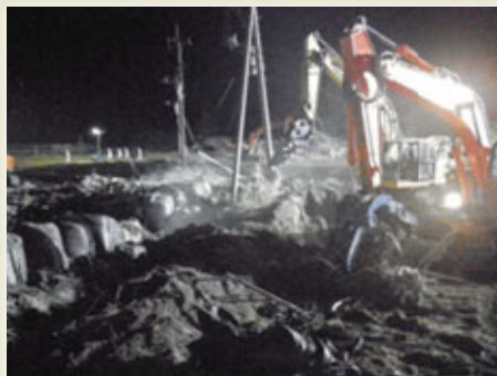
照明を設置して24時間態勢で復旧作業にあたる地元建設業者。
