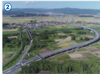
② 国道349号 那珂常陸太田拡幅
