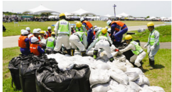
法崩れ防止工事を実施しました
