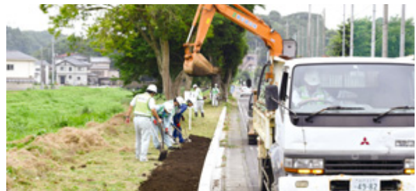
重機を用いて黒土を搬入しました
