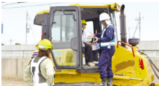
常北校の室伏さんは情報化施工も体験
