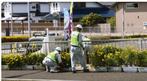
プランターの運搬・設置を行いました
