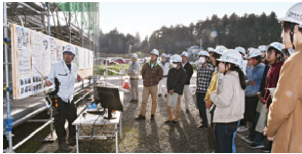
橋梁の工事現場を見学しました
