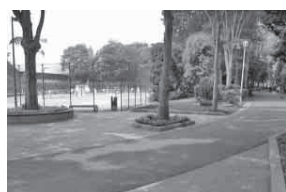
つくば市洞峰公園園路改修工事
