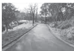
筑波大学 外構改修工事
