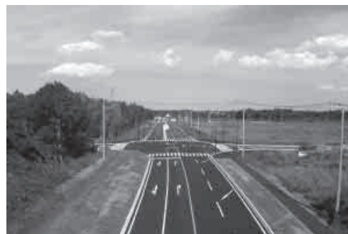
道路改良舗装・下水道工事
