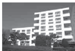
つくば市二の宮団地1号棟 他2棟外壁修繕その他工事
