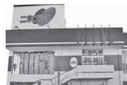
つくば市二木ゴルフ新築工事
