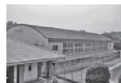
高山中学校 体育館新築工事
