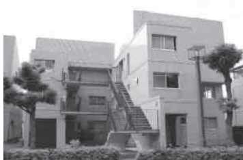
つくば市県営小野崎アパート 新築工事
