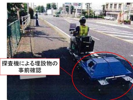
探査機による埋設物の事前確認
