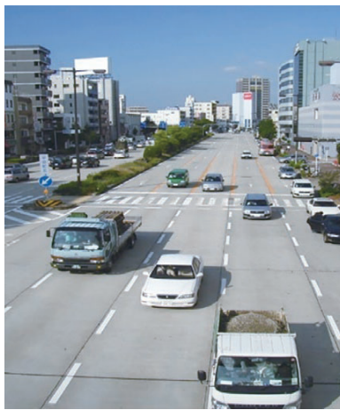
コンクリート舗装
