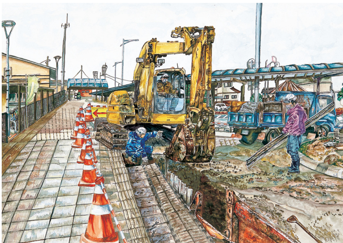
小中学生による建設工事風景図画作品
