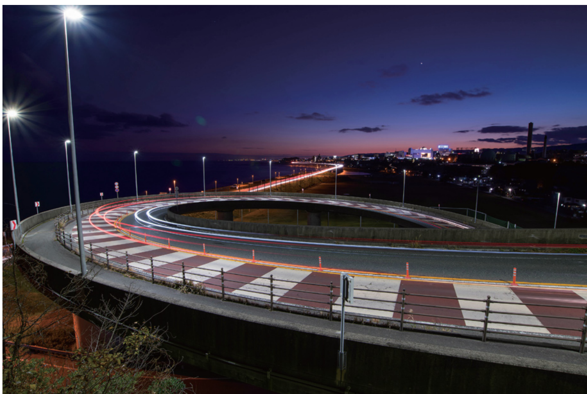
いばらき「建設フォトコンテスト」 A部門 建設のある茨城の風景 テーマ 地域を支えるインフラ
