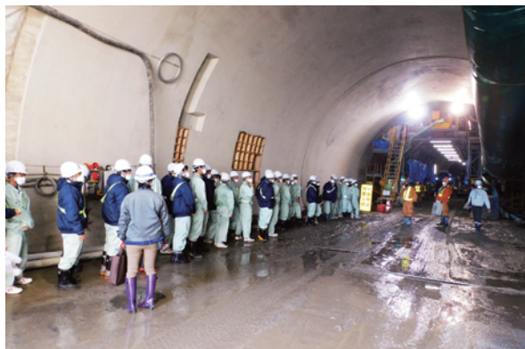
現場見学会で建設業の魅力をアピール
