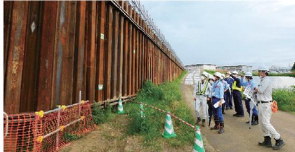
本会は7月26日、国土交通省関東地方整備局と荒川上流河川事務所管内の「入間川右岸古谷樋管改築工事」（埼玉県川越市）の現場で「鋼矢板二重式仮締切」の現地見学会を開催。災害時に対応するため、施工事例の少ない鋼矢板二重式仮締切を見学し、施工手順などを学びました。
