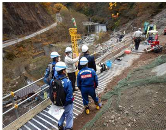
現場の安全総点検・パトロール実施状況
