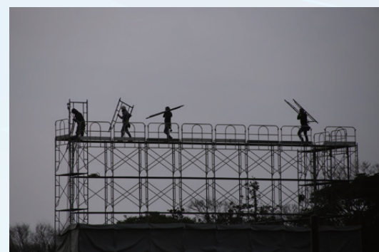
「足場解体」 茶山 昌子
