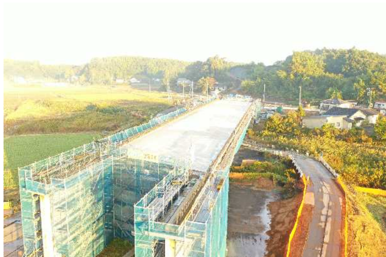
橋梁の施工状況
