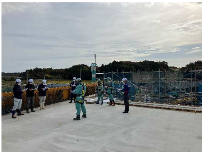
橋梁(床板)上で工事概要説明
