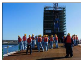
茨城港大洗港区水門上部工事
