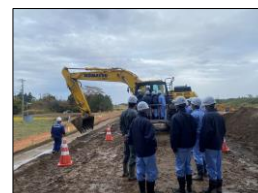
R3 那珂川右岸下大野地区築堤工事
