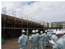
都和アパート17号棟建設工事
