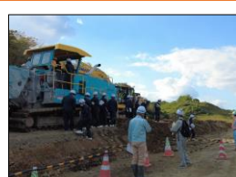
R3 久慈川土砂改良(その2) 工事
