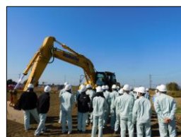
R3 那珂川右岸中大野地区築堤工事
