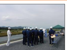
R2 那珂川左岸小場地区下流築堤工事
