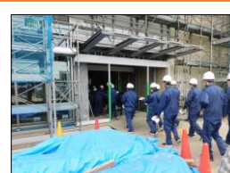
下妻市庁舎等整備工事
