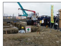
常総市 (仮称) 道の駅常総整備工事
