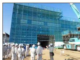
下妻市庁舎等整備工事
