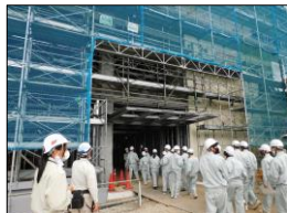
下妻市庁舎等整備工事
