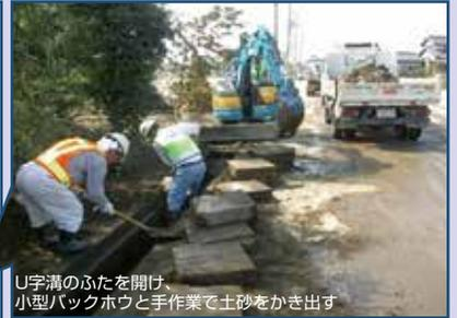
U字溝のふたを開け、小型バックホウと手作業で土砂をかき出す
