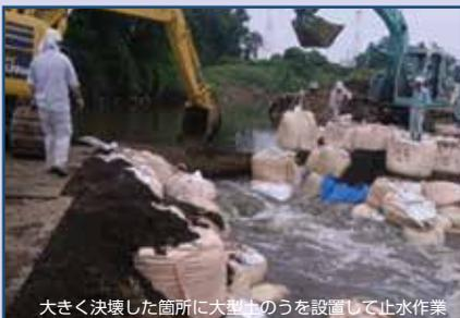
大きく決壊した箇所へ大型土のうを設置して止水作業
