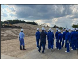
R4那珂川左岸野口排水樋管新設工事
