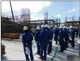
新斎場建設工事
