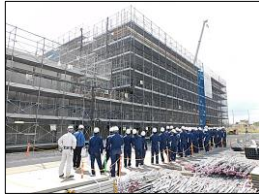
(仮称) みどりの南 小学校・中学校建設工事
