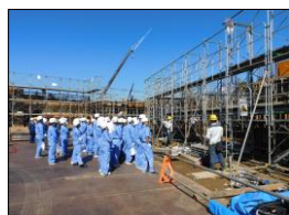
新斎場建設工事
