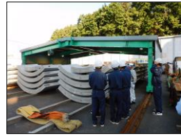
R3霞ヶ浦導水石岡トンネル (第1工区)新設工事
