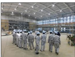
下稻吉中学校屋内運動場新築工事
