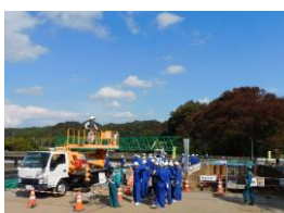
R4久慈川袋田地先南田気橋下部工新設工事
