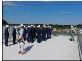
東関道(潮来~鉢田) 塔ヶ崎工事高架橋(鋼上部)工事
