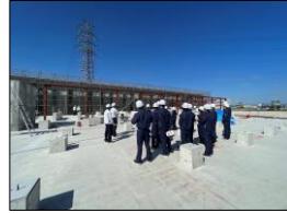
(仮称) みどりの学校プール建設工事
