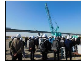
R3圏央道利根川橋上部工事
