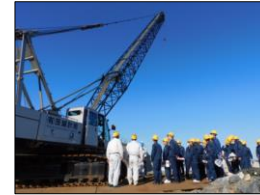
突堤整備工事
