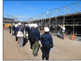
新斎場建設工事
