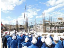
(仮称) 桜川市複合施設建設工事
