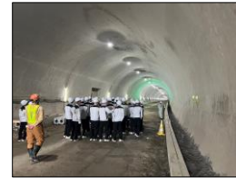
(仮称)上曽トンネル本体工事(石岡工区)
