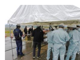
橋梁上部工事(光安寺橋)
