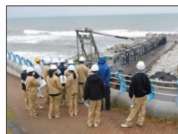
突堤整備工事
