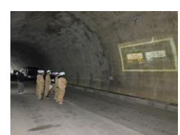
(仮称)上曽トンネル設備関係工事
