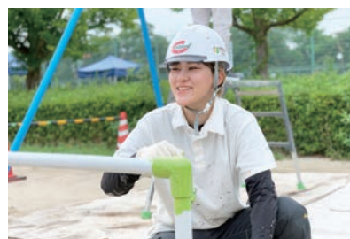
▲塗装工事の作業風景
