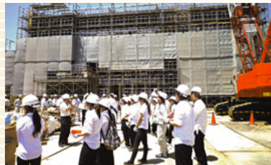
建設現場見学会 ▶
