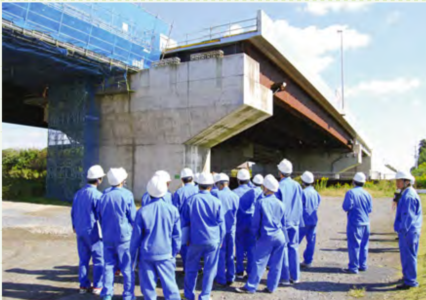
橋梁工事の現場見学会
