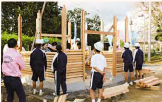
校倉工法による組立作業
