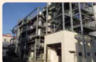
次世代型焼却システム
