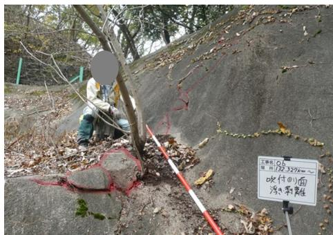
図-3 変状の状況 木による吹付コンクリートの破損状況
