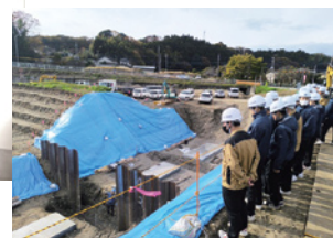
現場見学会 (土木系)
