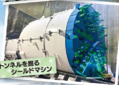
建設中のトンネル内に潜入！
