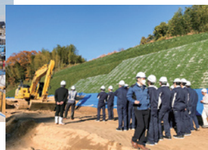
現場見学会（土木系）
